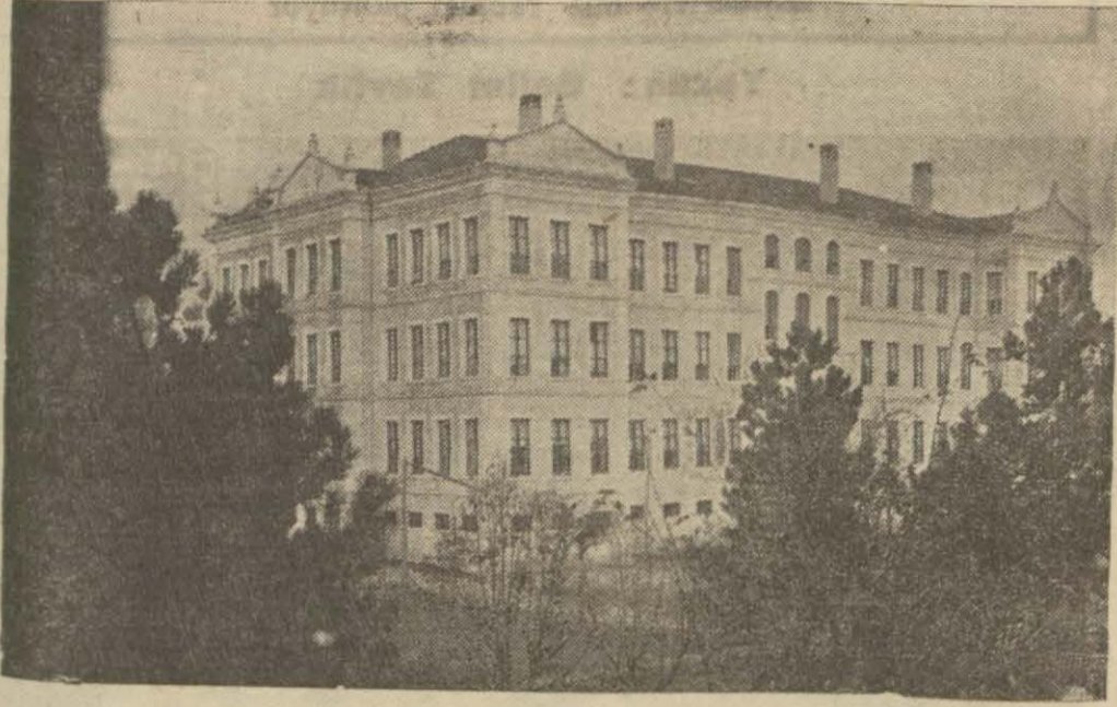
Bolu hükûmet konağı
